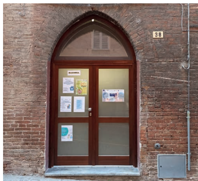
L'ingresso della Casa Accoglienza in via Mamiani
